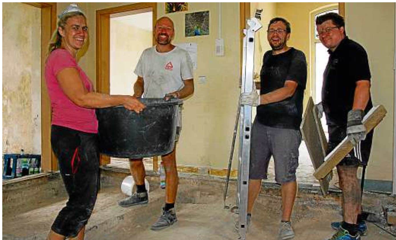
Tanja Ernst-Adams, Frank Maurer, Florian Probst und Christian Heyder halfen bei der Demontage der Dielung im Erdgeschoss, wo eine Fußbodenheizung eingebaut werden soll. Fotos (3): Angelika Schimmel
